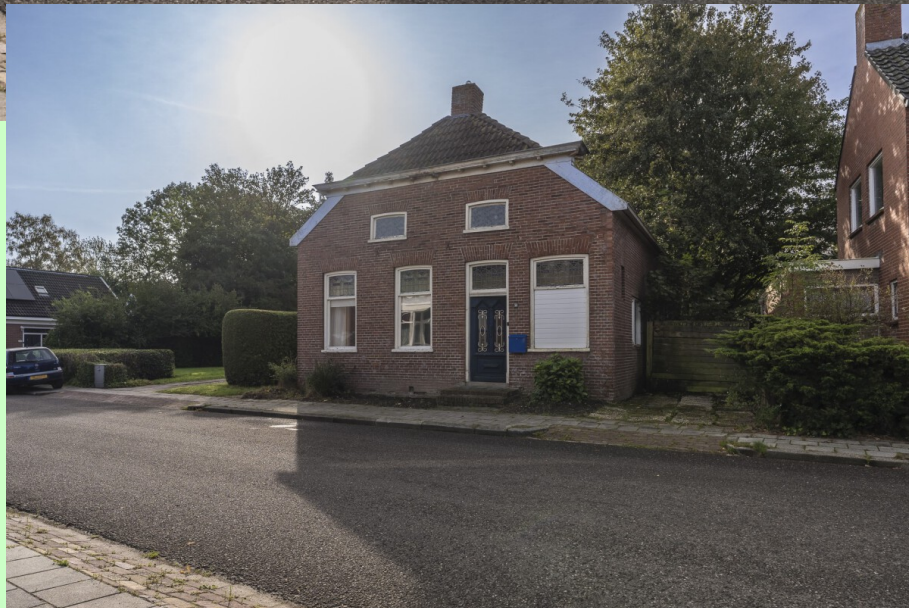
Hoofdweg 51 te Finsterwolde
